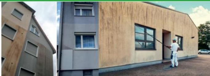
Bild 1: vorher/nachher Bild2: Musterfläche Bild3: Bei der Arbeit
